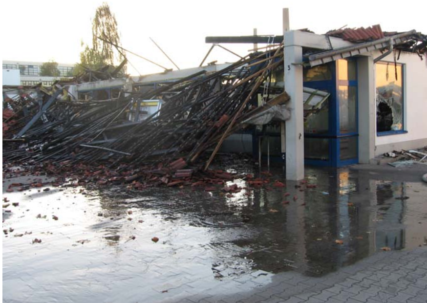
Foto: Zugangsöffnung des Angriffstrupps
